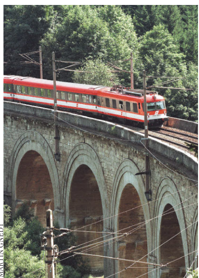
Ghegastrecke: Droht Gefahr vom Tunnel?
