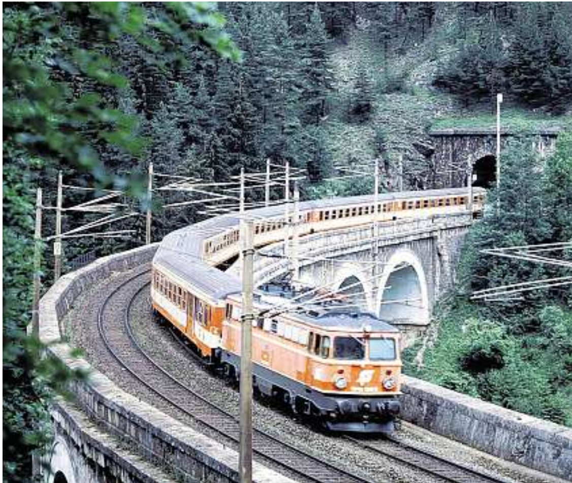
Zumindest bis 2020 wird am Basistunnel gebaut, aber was passiert dann mit dem Weltkulturerbe Ghega-Bahn?
